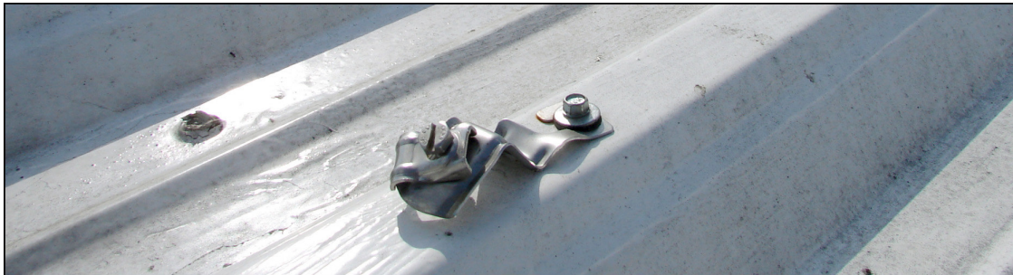
Zdjęcie 2. Wyrwany zwód przez zsuwającą się po blasze czapę śniegu.
