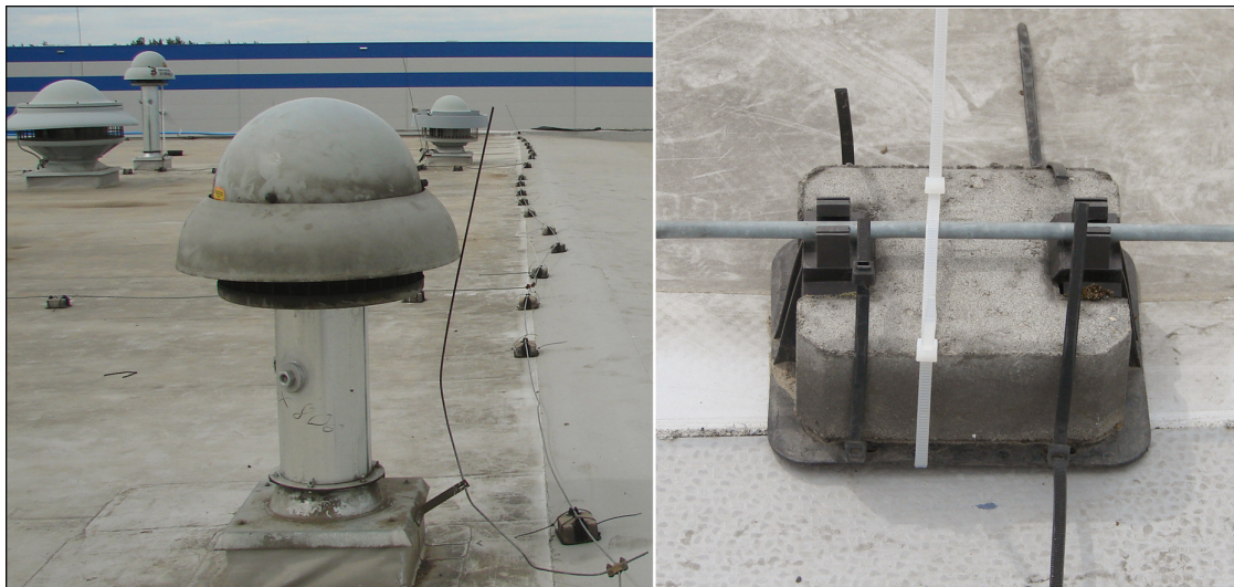
Zdjęcie 8. Typowy obraz spotykany na dachach. Dla firm budowlanych, dla których podwykonawcy wezwani w końcowym etapie budowy budują instalacje odgromowe, problem jakości nie istnieje.
