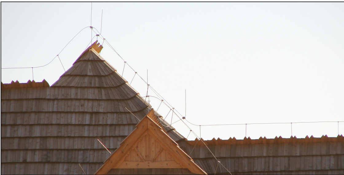
Zdjęcie 7. Wątpliwa ozdoba dworku wykonanego z bali drewnianych, krytego gontem; czyżby architektowi to nie przeszkadzało?
