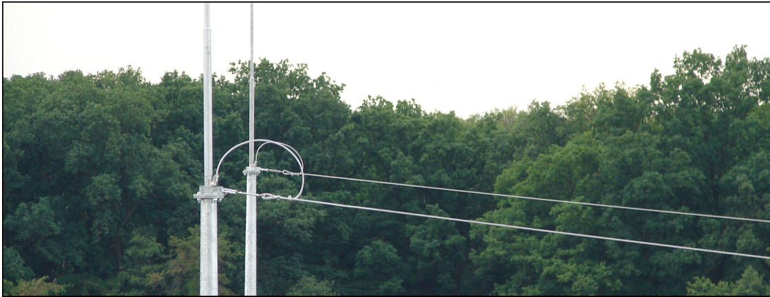
Zdjęcie 3. Zwody izolowane oparte na 22 metrowych masztach odgromowych chroniących zbiorniki spirytusu.
