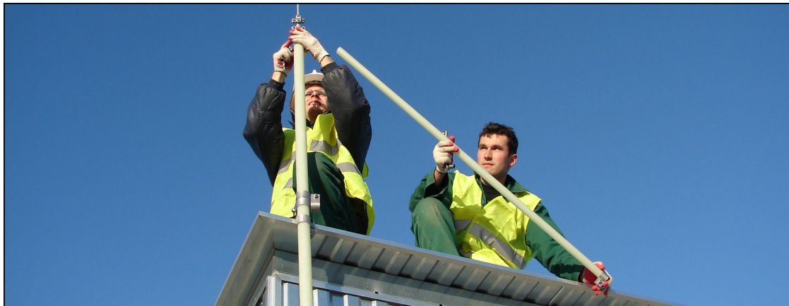
Zdjęcie 7. Montaż zwodów odsuniętych na centrali klimatyzacyjnej.
