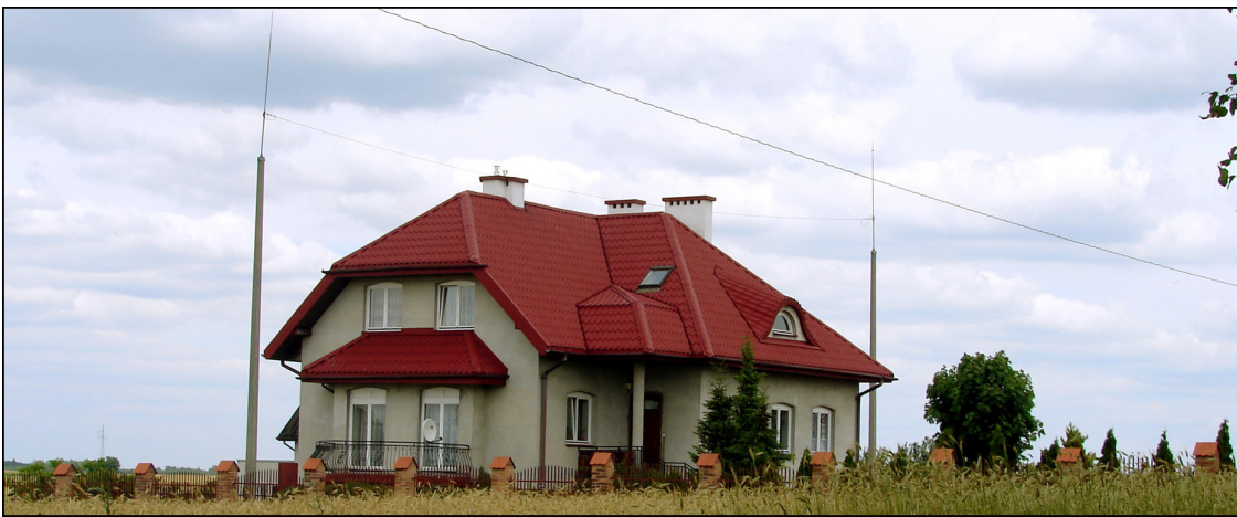
Zdjęcie 4. Typowy zwód izolowany w układzie dwuwymiarowym zastosowany do ochrony domu jednorodzinnego.
